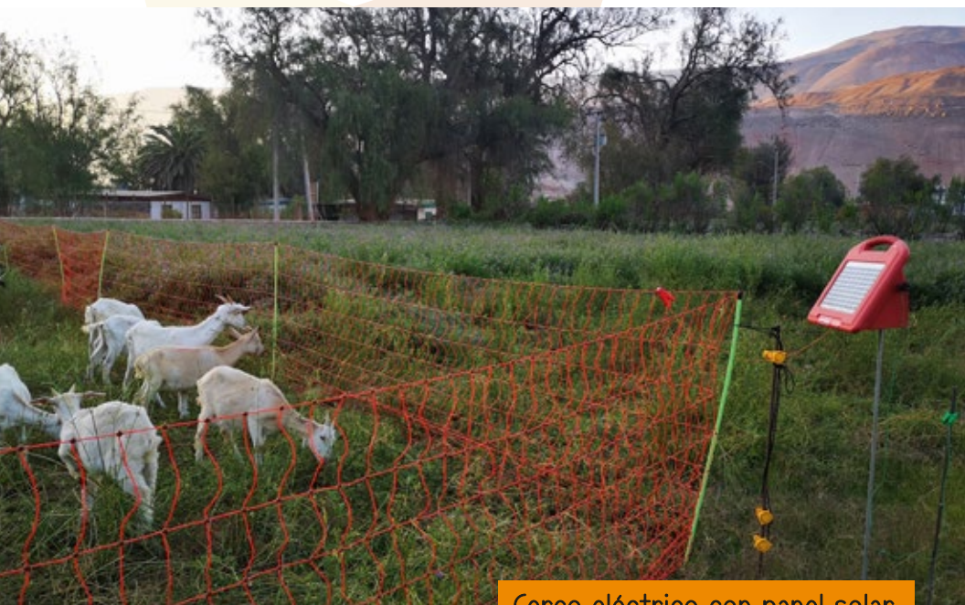
Cerco eléctrico con panel solar.
